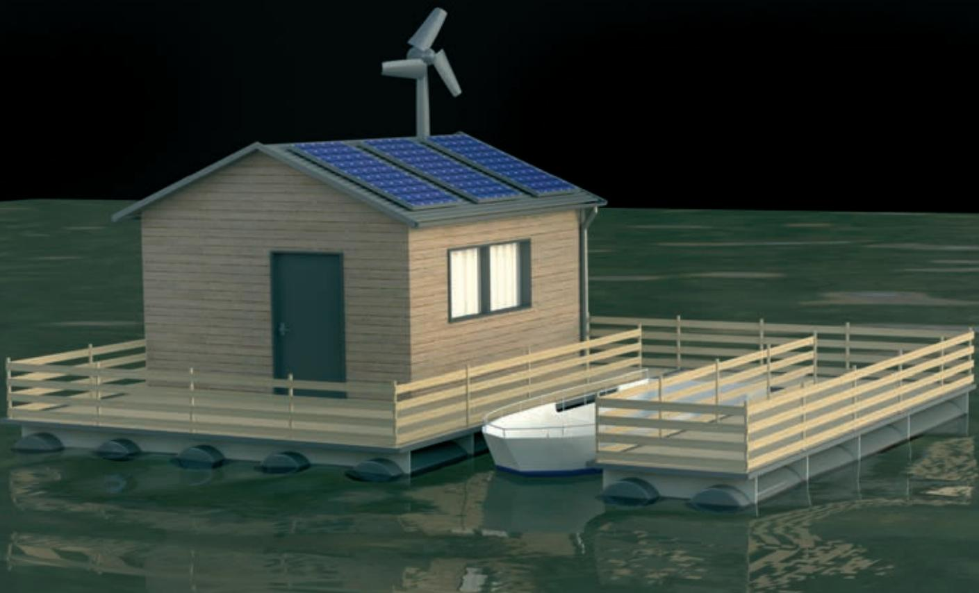
Ponton-sojenica je energetski neovisan objekt. Svu potrebnu energiju i ostale resurse moguće je dobiti iz prirodnih izvora putem vjetrenjače, fotonaponskih ploča, uređaja za akumuliranje i korištenje kišnice. Prethodno navedeni uređaji projektirani su i izvedeni u skladu s normama i zahtjevima propisanim od strane Europske unije te posjeduju odgovarajuće certifikate koji dokazuju njihovu sukladnost. Rad samih uređaja ne šteti okolišu te u potpunosti zadovoljava sve potrebne ekološke standarde.
